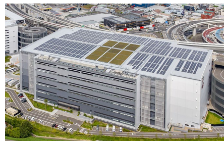
「省エネ性能の高い建築物」のイメージ ZEB Ready/太陽光発電（DPL新横浜）
