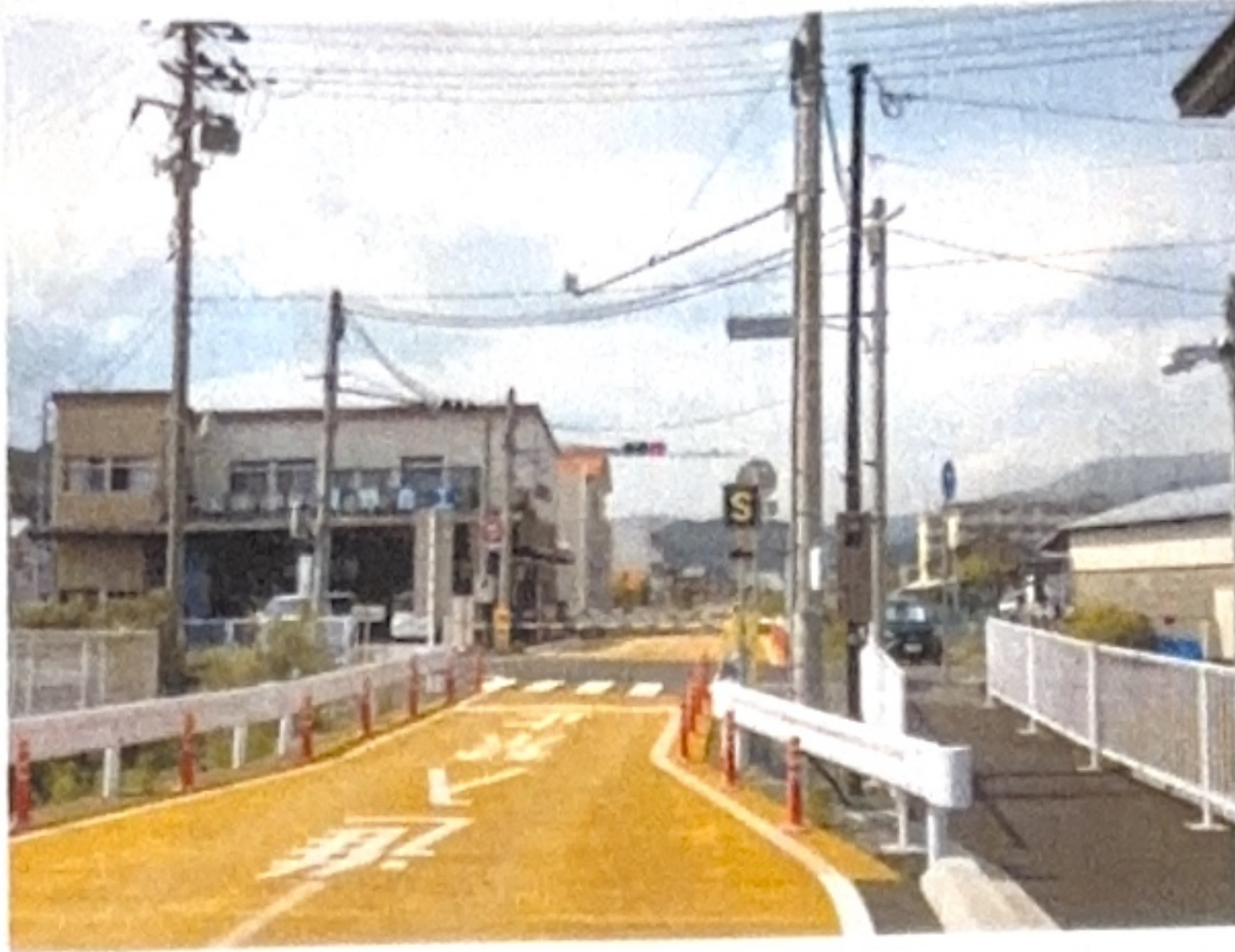
専用道と一般道との交差点（田茂山駅付近）
