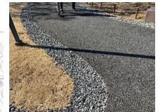
透水性 アスファルト舗装 (イメージ)
